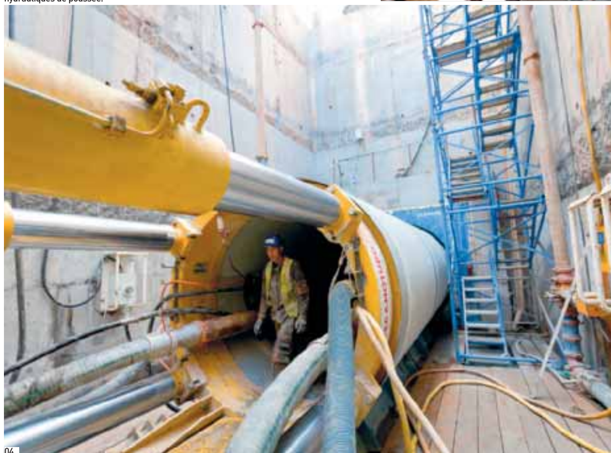
04_ Un des puits d'attaque du chantier, avec des vérins hydrauliques de poussée.
