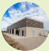
usine du SIE de la Vaunage (30), France 400 m 3 /h
