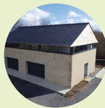
usine du SIAEP d'Evran (22), France 100 m 3 /h
