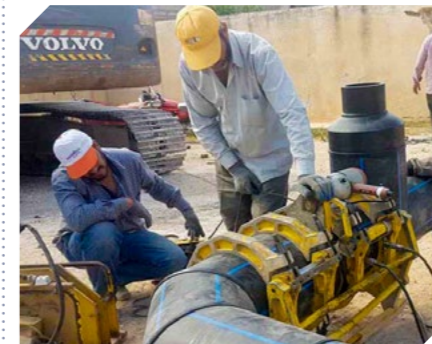
Les infrastructures sont gravement détériorées
