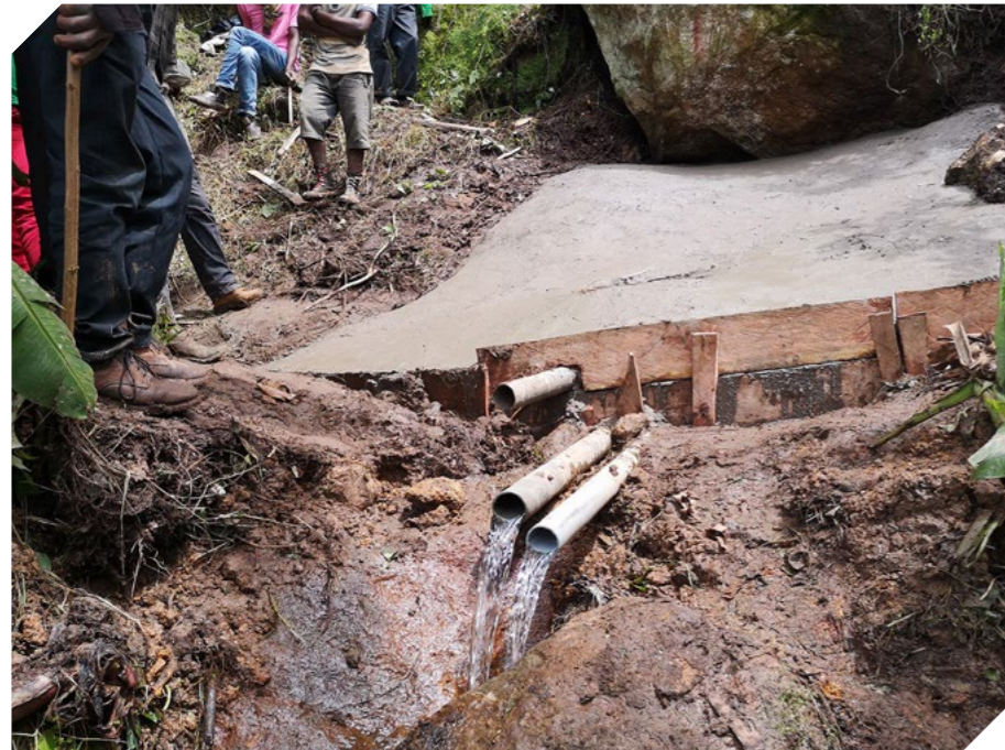
Les habitants participent à la réalisation des travaux d'adduction
