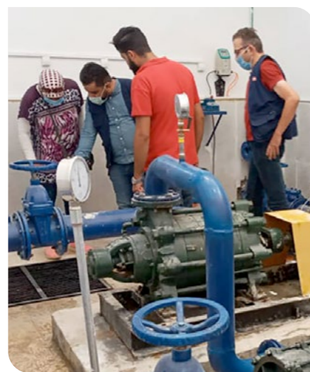
Rétablir et renforcer les infrastructures
