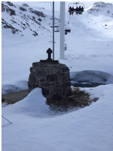
Système de captage au cœur des pistes de la station des Menuires
