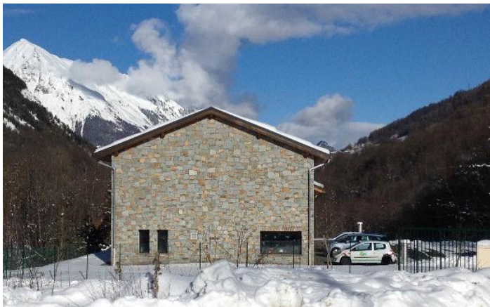
La station de traitement des eaux usées de Villarenger, : un parfait exemple d'intégration paysagère.
