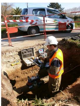
La méthode Scanner consiste à analyser l'état de la canalisation sans l'ouvrir, une sorte d'échographie.
