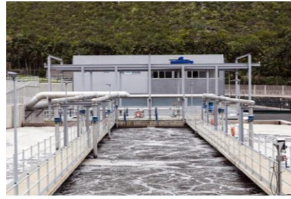
Surveillance du Covid-19 dans une station d'épuration
