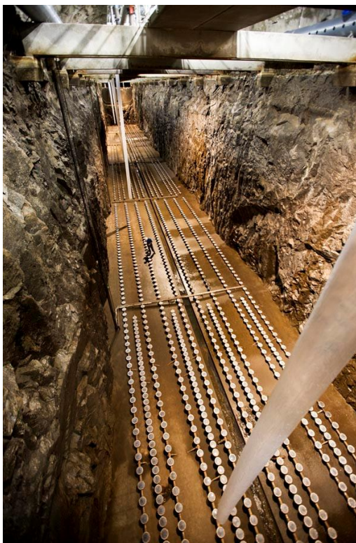
Bassin d'aération de la station de traitement des eaux usées Henriksdal - Stockholm ©SUEZ
