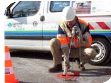
Détection de fuites (France)
