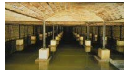
Bordeaux - Réservoir Budos
