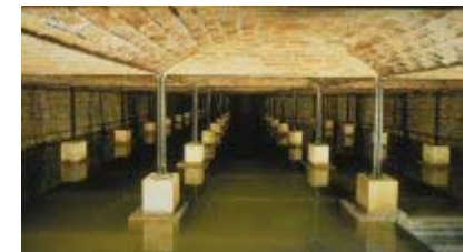
Bordeaux - Réservoir Budos
